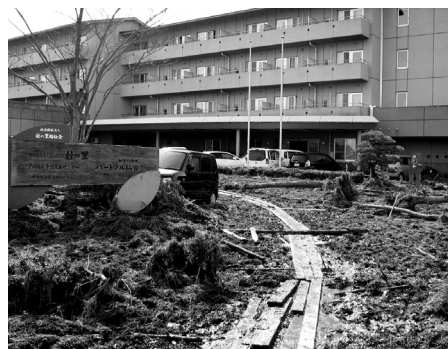
津波による海水が引いた後の「杜の里」の周辺。
