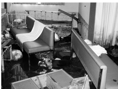
施設内は1階部分がすべて泥と海水で埋め尽くされたという。写真は被災直後の1階の様子。
